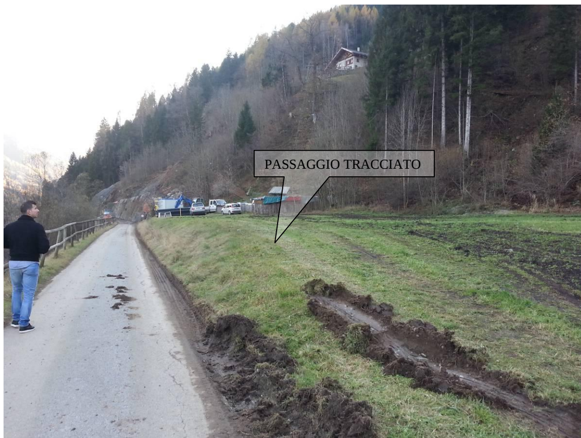
VISTA DALLA SPONDA DESTRA
