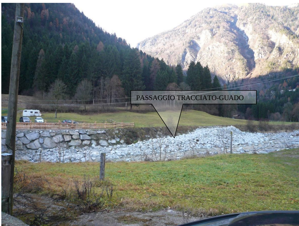
VISTA GUADO PER TRACCIATO AGONISTICO A MONTE PONTE LOC. BO'
