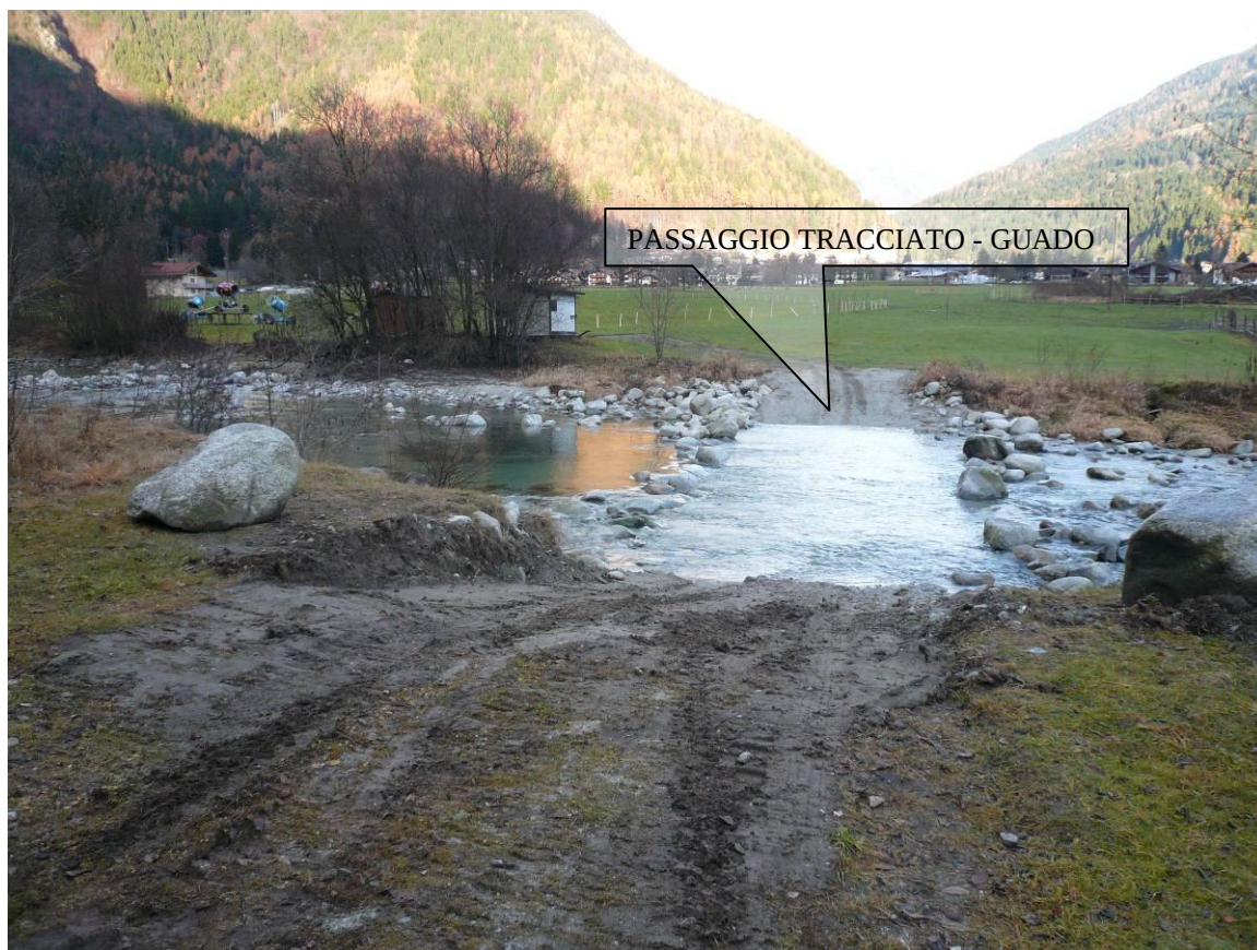
VISTA AREA GUADO TEMPORANEO SUL SARCA DI GENOVA A CARISOLO
